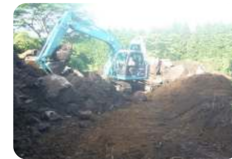
道路復旧・改良
