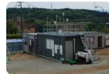
無人化施工の操作室
