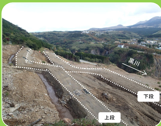
土留盛土工（熊本側より撮影）
