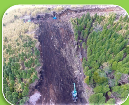
ガリー対策工施工状況
