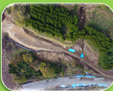
2号工事用道路ドローン撮影状況
