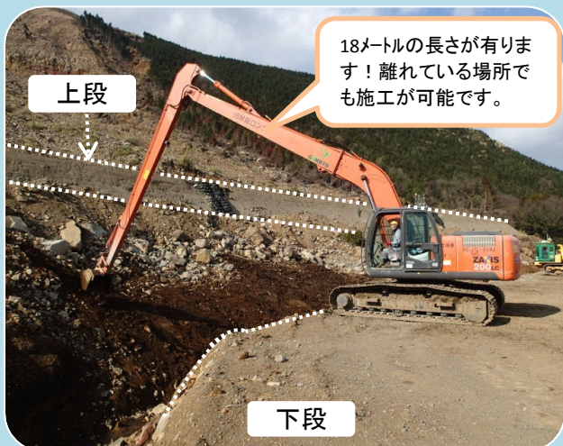
下段捕捉部掘削状況
