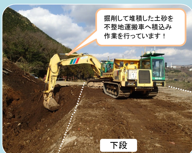
掘削後土砂運搬状況
