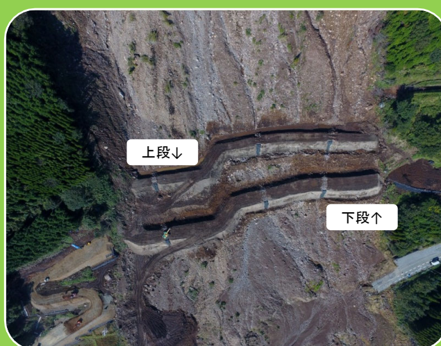
土留盛土工（ドローンによる撮影）
