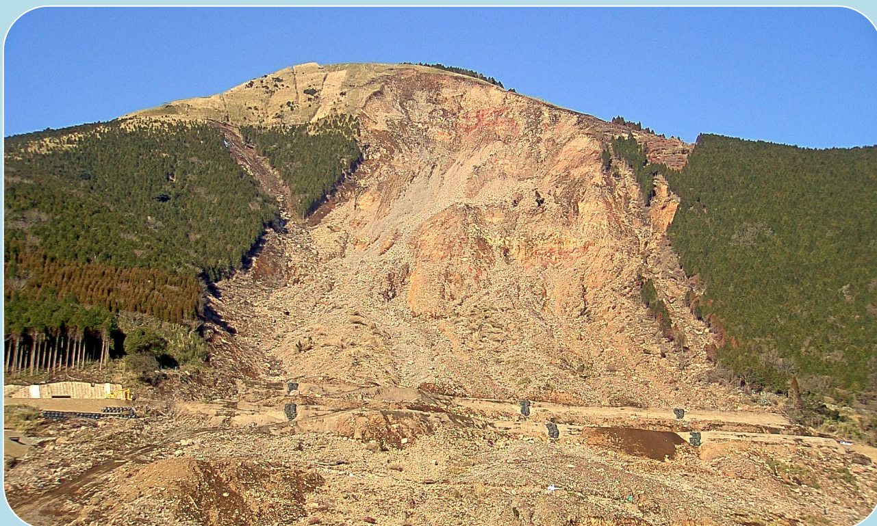
阿蘇大橋地区斜面崩壊対策の進捗状況 （平成29年1月26日撮影）
