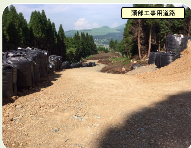
頭部工事用道路(大分側ルート)全景写真
