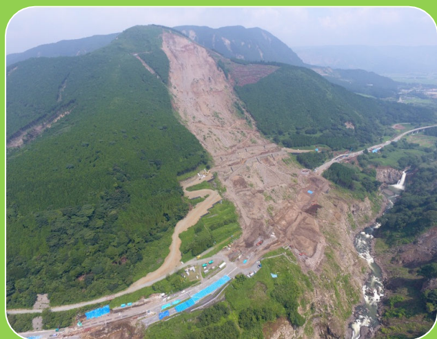
全景写真（ドローンによる撮影）
