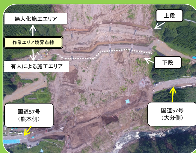
土留盛土工（ドローンによる撮影）
