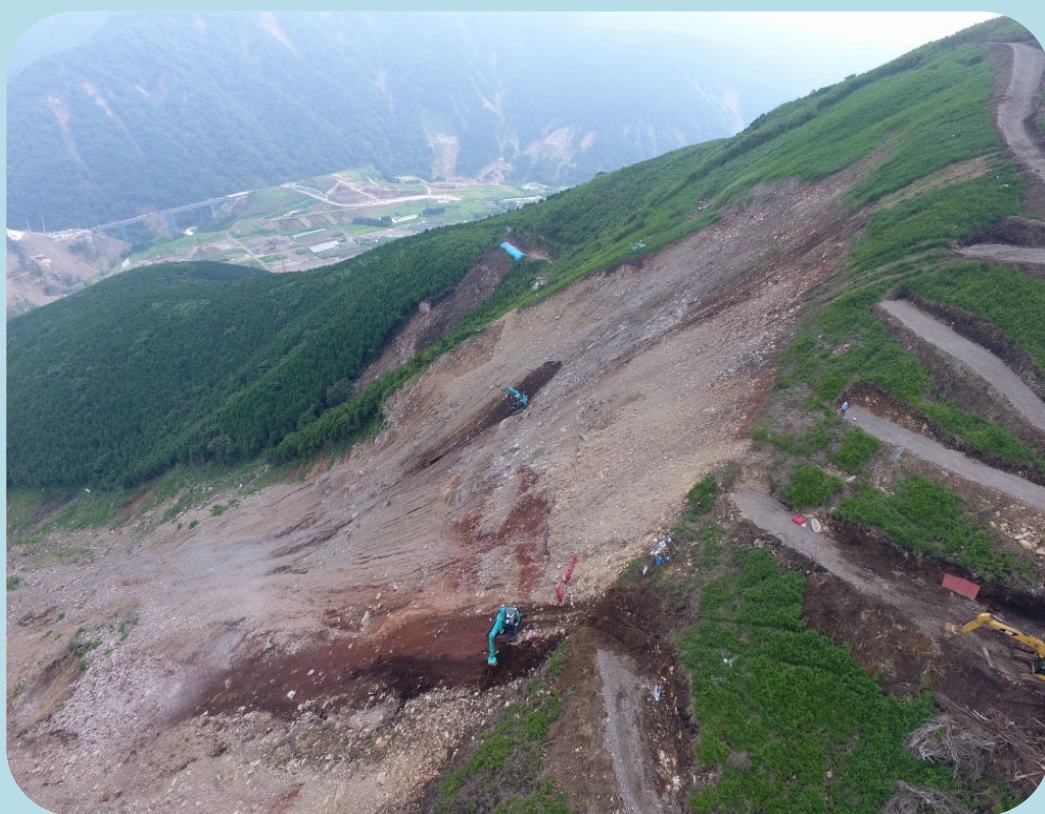
阿蘇大橋地区斜面崩壊対策の進捗状況（平成29年7月24日撮影）
