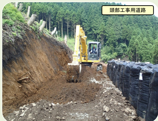
頭部工事用道路(山頂ルート)施工状況写真
