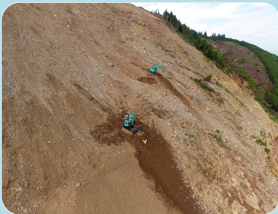
阿蘇大橋地区斜面崩壊対策の進捗状況（平成29年9月ドローンによる撮影）
